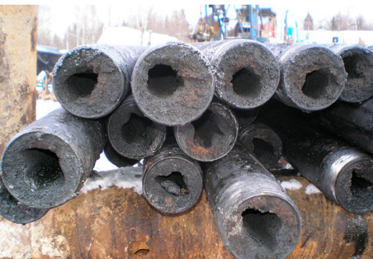
Corrosión por H 2 S
